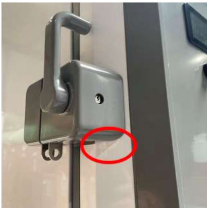
Lackbeschädigung unterhalb des Türgriffes
